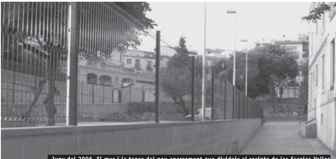
Juny del 2006. El mur i la tanca del nou aparcament que divideix el recinte de les Escoles Velles
