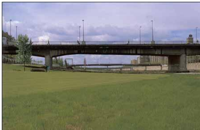
Fig. 8. Interior del espacio de aguas altas.
