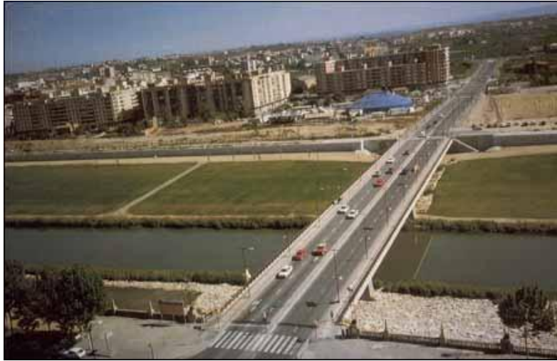
Fig. 9. Vista desde la margen derecha.
