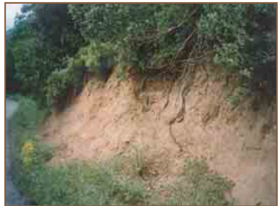
Talús de sauló, en el qual la roca granítica esdevé gairebé pols a causa de l'erosió.
