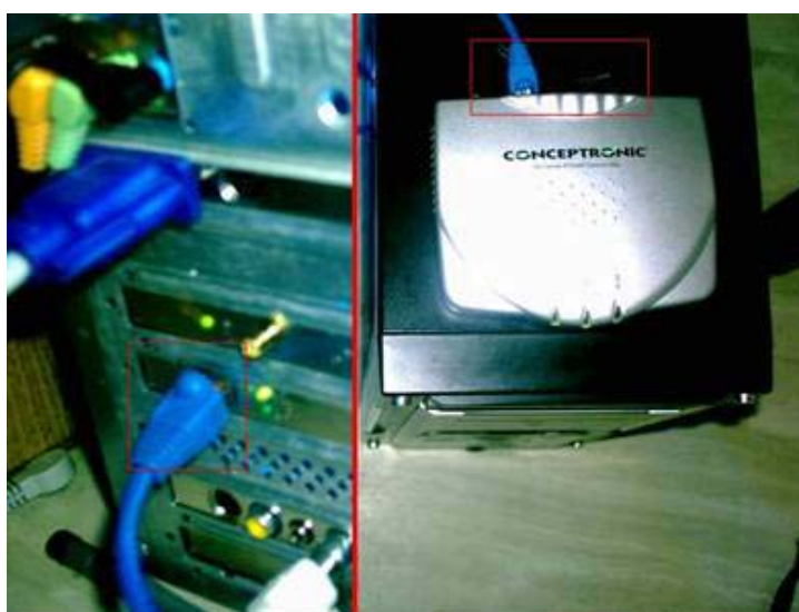
Imatge 4: Instal·lació del AP o Router Wireless (AP en aquest cas).
