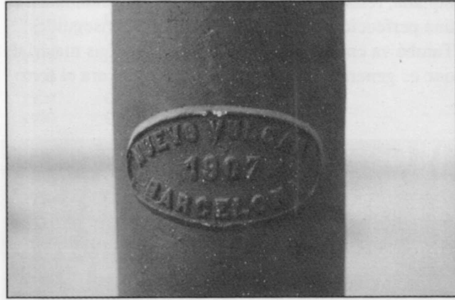
Columna de ferro colat fabricada per l'empresa metal·lúrgica de la Barceloneta "Nova Vulcano".
