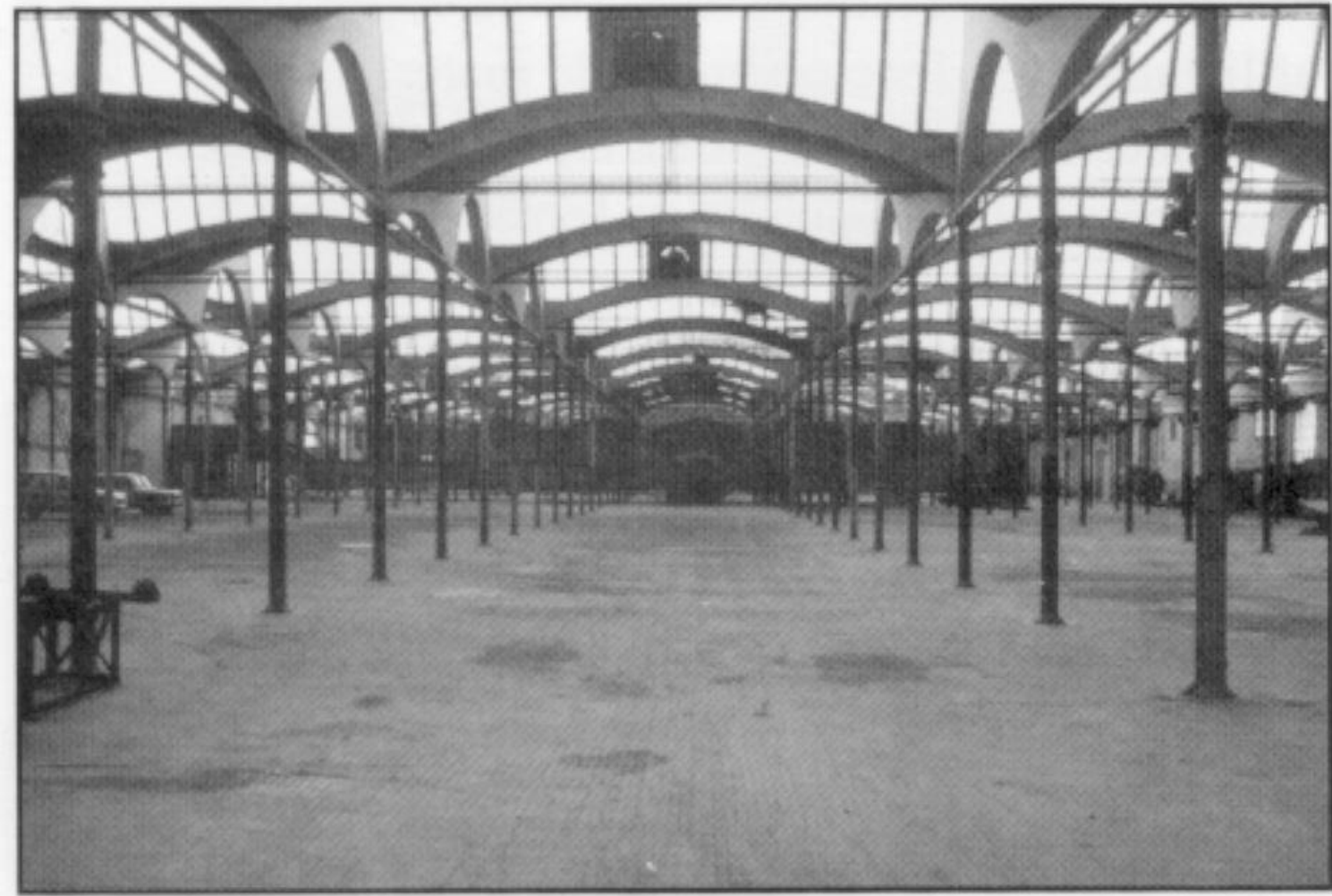
Interior de la gran nau de producció. Cal destacar-ne la gran lluminositat aconseguida per les claraboies.
