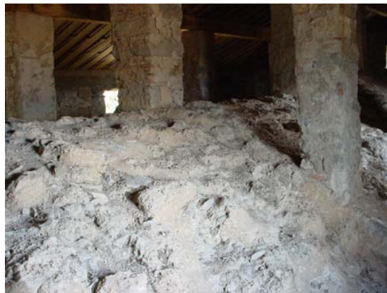
El teulat està suportat per pilars que es recolzen sobre la volta
