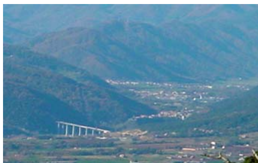
Viaducte de Castellfollit de la Roca
