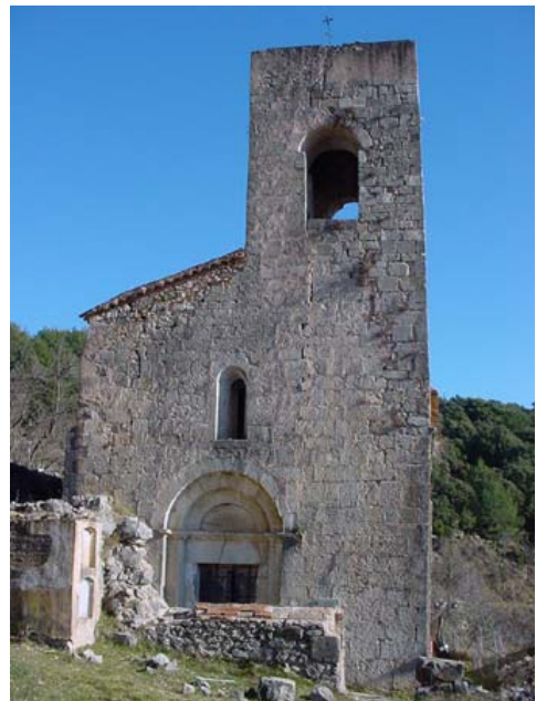
Façana de St. Andreu de Lliurona i l'antic cementiri
