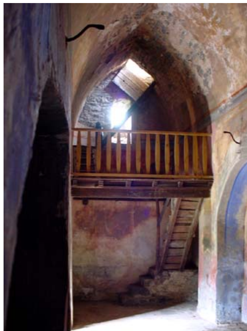
La porta, el cor, de fusta, i l'accés al campanar
