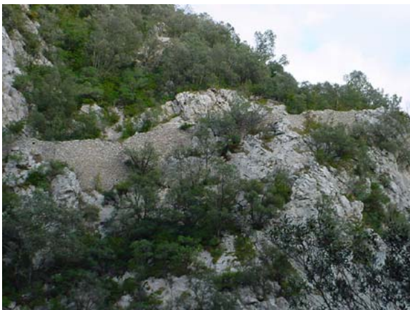
El paraments de pedra que fan de suport al camí
