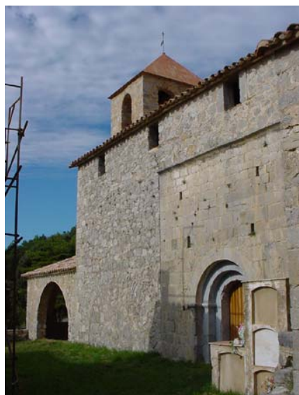
A St. Grau es diferencien perfectament les dues èpoques de construcció
