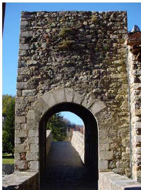
Aquesta dóna accés al Pont Nou des del poble
