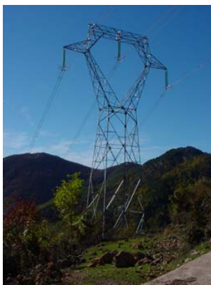
Línia elèctrica de 400 kV al mas Blanc, prop de Camprodon
