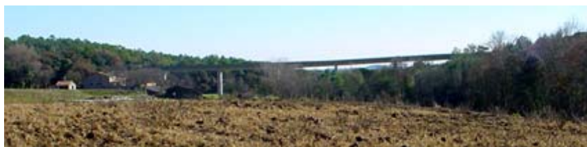
Pont de la carretera A-26 al seu pas per Cabanelles
