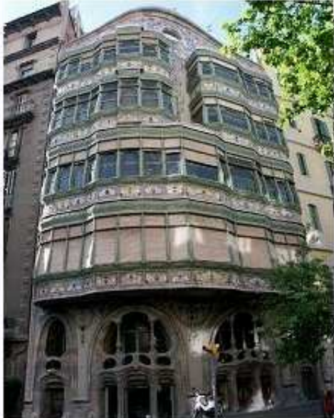
Casa Comalat (darrera) C/. Còrsega, 316 (Barcelona)
