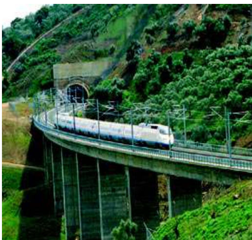
El recorrido de alta velocidad Madrid-Barcelona tendrá 47 km de viaductos y 50 km de túneles. Este importante número de puentes y viaductos minimizan el impacto ambiental sobre el territorio.
